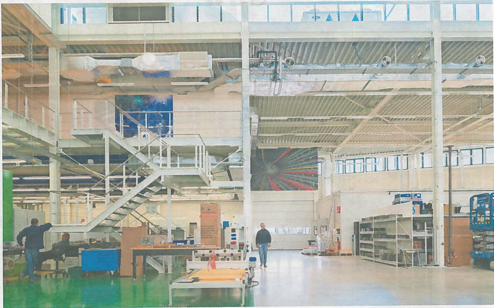
In een deel van de 12 meter hoge hal kunnen later tussenvloeren worden gemonteerd om ruimte te maken voor nieuwe activiteiten. Foto: Menno Emmink
